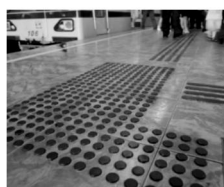
盲道由凸起的棱和圆点组成
