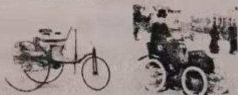
上图中左边是第一辆汽车——奔驰 1 号;右边的是世界上第一辆拥有斜转向柱与倾斜方向盘的汽车。
